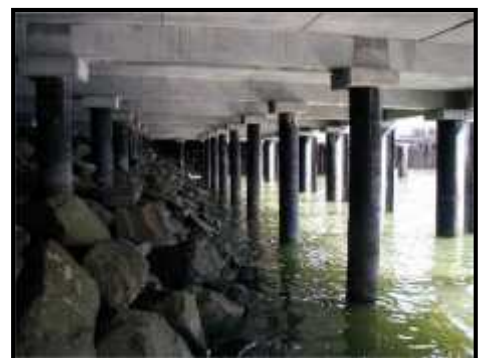
Figure 205 : système constructif de la plateforme.
