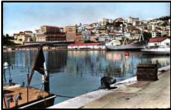
Figure 56 : La façade maritime de la ville de Bejaia. Source : https://lh3.googleusercontent.com/7Sibws-aGHka6lZx0kTDHkrUZwAdrY2b4Xfsp4DAMB7nlu9Aqci3cNnJZf-WtQECmNJIQ=s134
